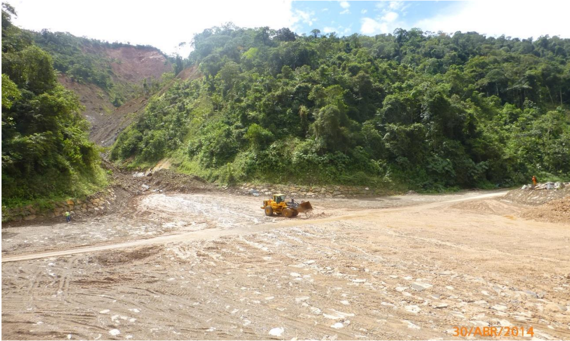
Vista del cono de deyección de la quebrada, limpieza después de un acontecimiento detrítico. Para garantizar la transitabilidad.
