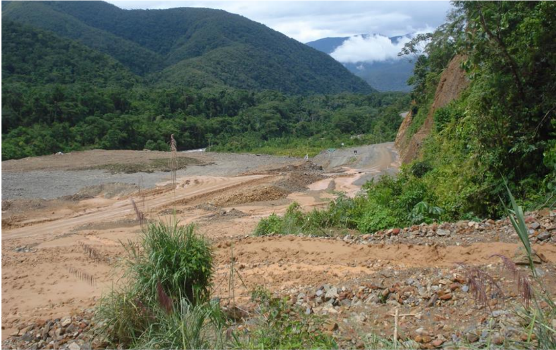
Margen Derecha de la quebrada, talud de formación rocosa meteorizada.
